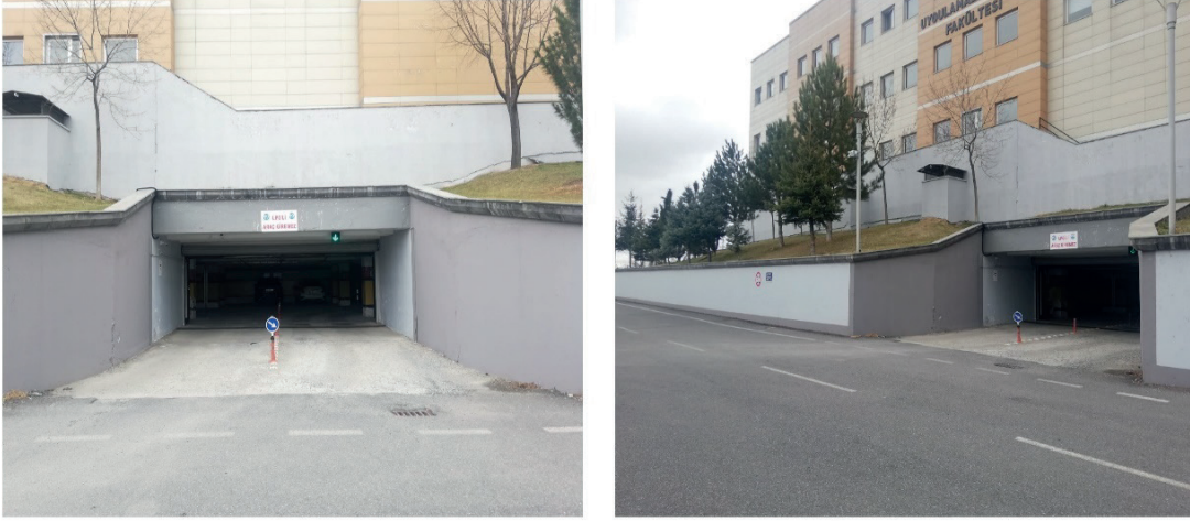
Fotoğraf 3: Kapalı Otopark Dış Cephesi
