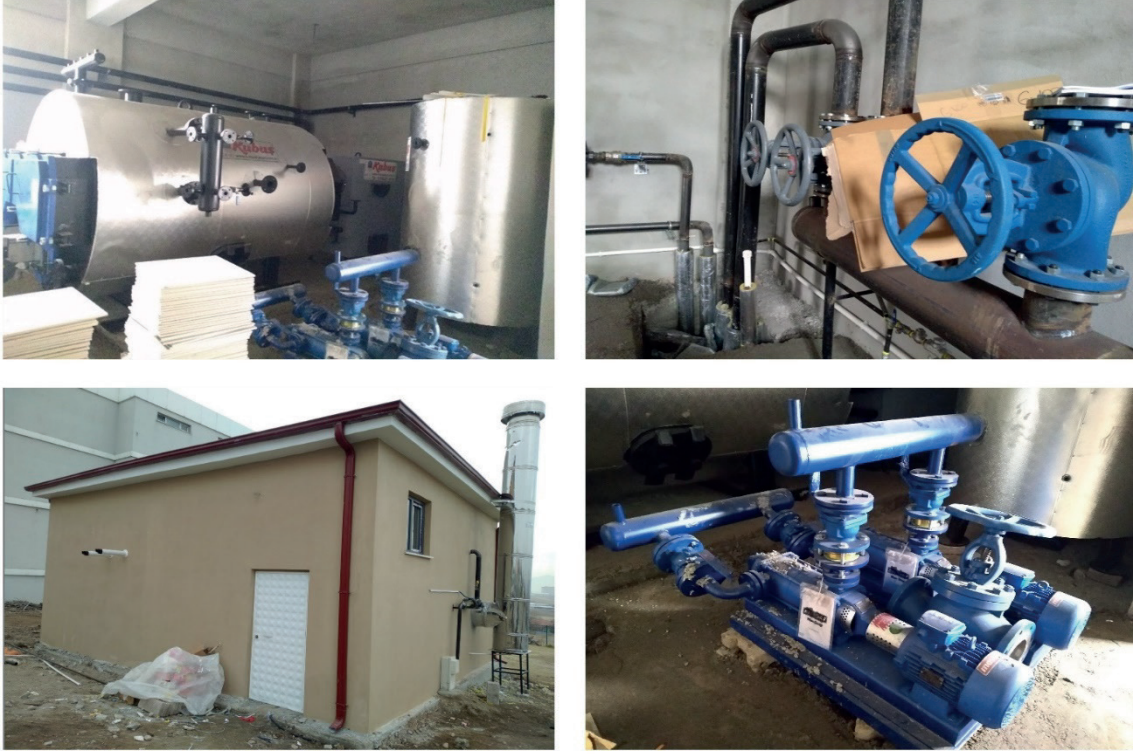
Fotoğraf 36: Buhar Kazanı Yapım
