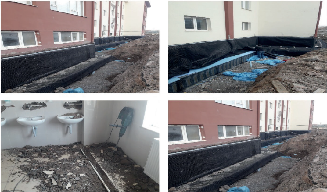
Fotoğraf 34: Develi MYO, Yeşilhisar MYO ve Bünyan MYO Bazalt-Bohçalama-Drenaj
