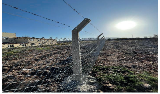
Fotoğraf 33: İncesu Yerleşkesi İstinat Duvarı ve Tel Örgü Yapımı
