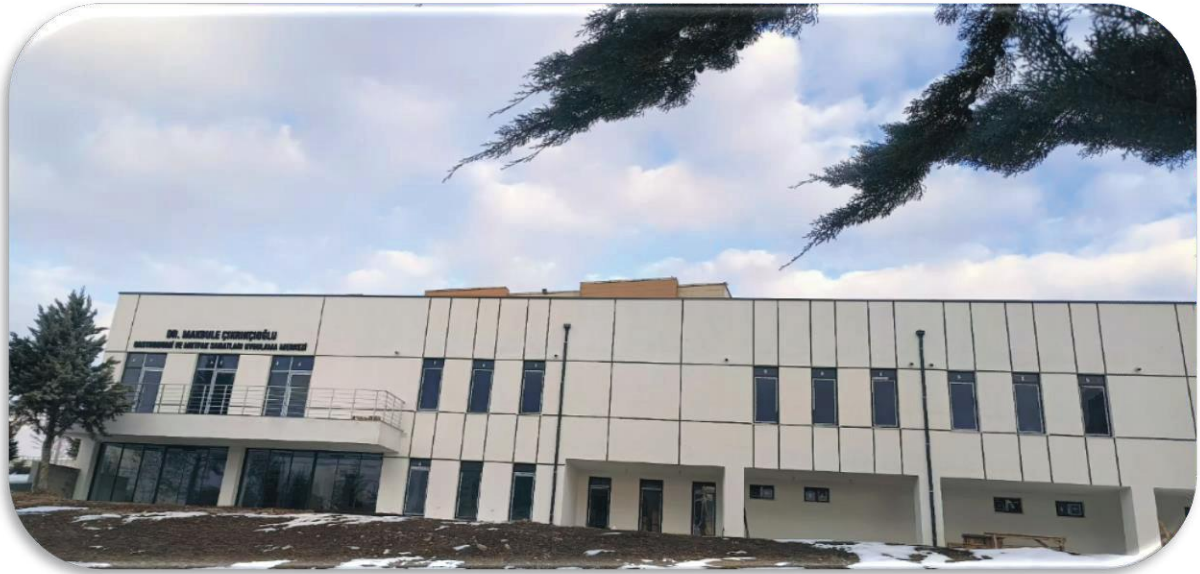
Dr. Makbule Çıkrıkçıoğlu Gastronomi ve Mutfak Sanatları Uygulama Merkezi inşaatı
