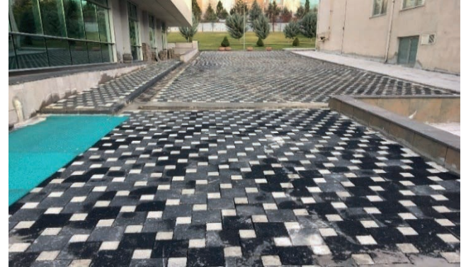
Fotoğraf 25: Kütüphane Binası ile Kongre Binası Yanı Kilit Taş, Andezit, Bazalt ve Izgara Uygulaması
