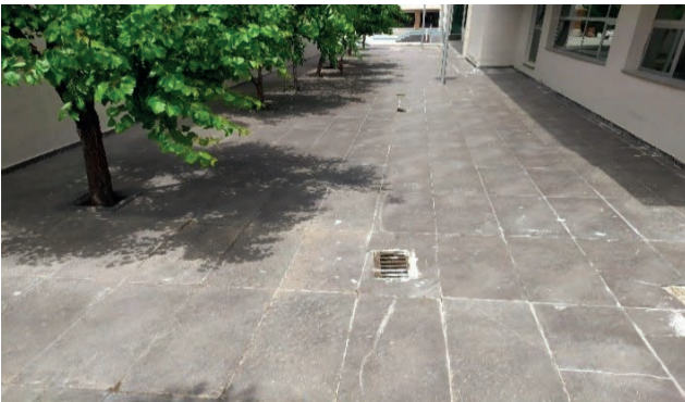
Fotoğraf 23: Yemekhane Binası ile Kapalı Spor Salonu Arası Bazalt Taş Uygulaması
