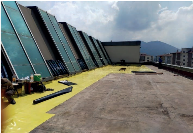
Fotoğraf 31: Teknik Bilimler MYO Binası Çatı Tadilatı Membran Kaplaması
