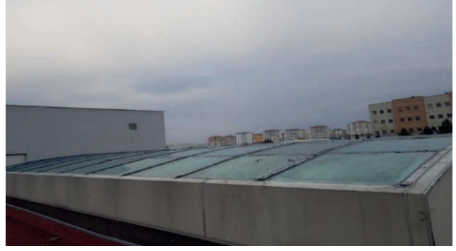
Fotoğraf 44: Kütüphane Binası Çatısındaki Cam Kenarlarına Mastik İşlemi
