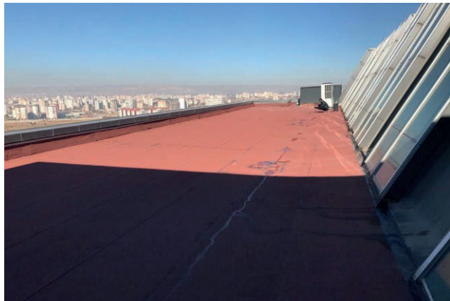
Fotoğraf 31: Teknik Bilimler MYO Binası Çatı Tadilatı Membran Kaplaması
