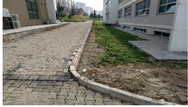
Fotoğraf 24: Gıda Çalışmaları Uyg. ve Arş. Merk. Çevresi Bordür, Kilit Taş ve Menhol Uygulaması
