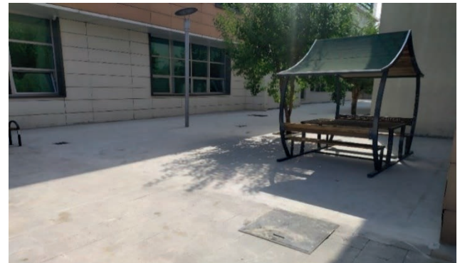
Fotoğraf 23: Yemekhane Binası ile Kapalı Spor Salonu Arası Bazalt Taş Uygulaması
