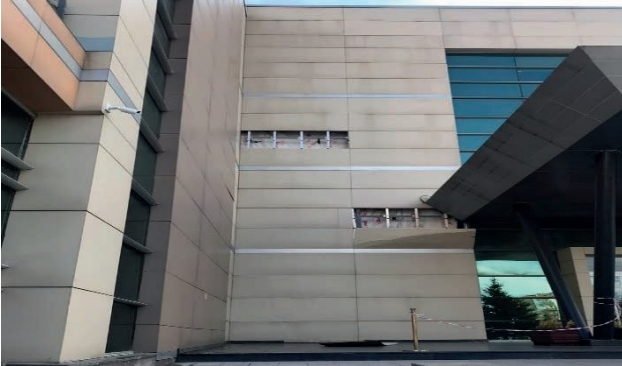
Fotoğraf 45: Rektörlük Binası Dış Cephe Kaplama Tadilatı
