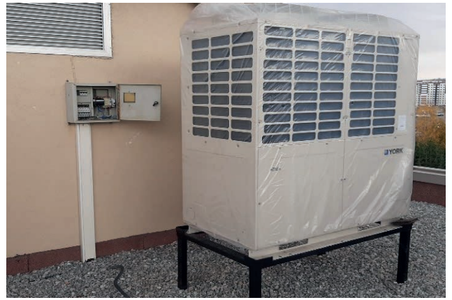
Fotoğraf 34: Mustafa Çıkrıkçoğlu MYO VRF Tesisatı
