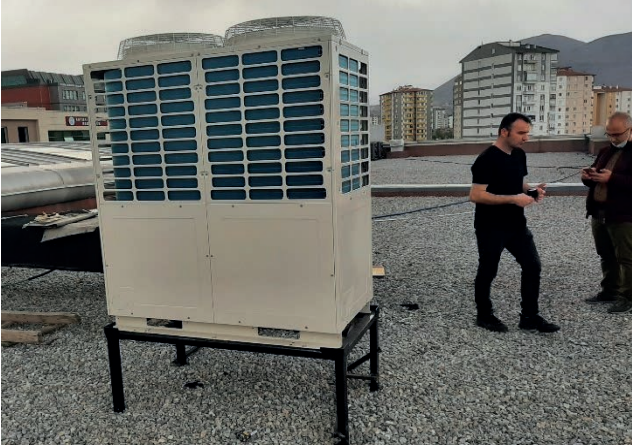
Fotoğraf 33: Uygulamalı Bilimler Fakültesi VRF Tesisatı
