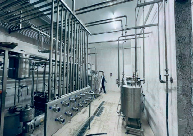
Fotođraf 38: Safiye ıkrıkiođlu MYO Gıda Teknolojileri Üretim Merkezi Buhar Tesisatı Yapım İŖi
