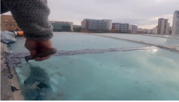
Fotoğraf 44: Kütüphane Binası Çatısındaki Cam Kenarlarına Mastik İşlemi
