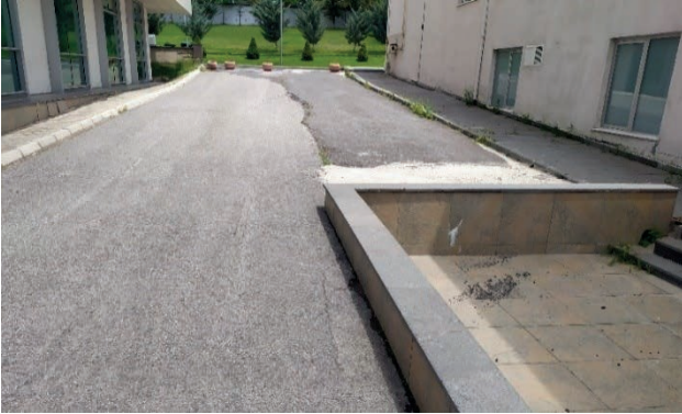
Fotoğraf 25: Kütüphane Binası ile Kongre Binası Yanı Kilit Taş, Andezit, Bazalt ve Izgara Uygulaması
