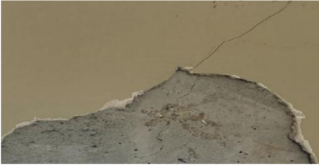
Fotoğraf 56: Yahyalı MYO Deprem Sonrası Oluşan Duvar Çatlakları
