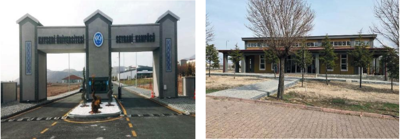
Fotoğraf 98: Develi Seyrani Yerleşkesi Nizamiye Girişi ve Develi Öğrenci Yaşam Merkezi
