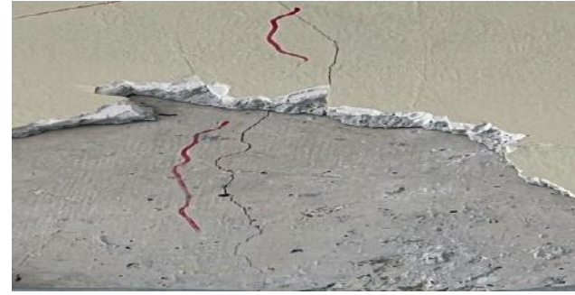
Fotoğraf 56: Yahyalı MYO Deprem Sonrası Oluşan Duvar Çatlakları
