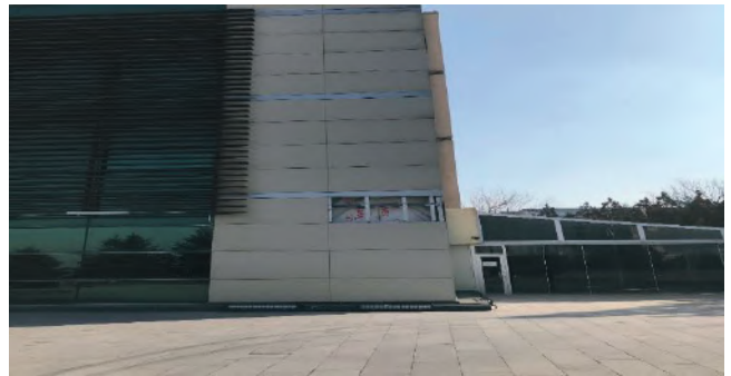
Fotoğraf 72: Rektörlük Binası Dış Cephe Kaplaması ve Kırık Parçaların Yenilenmesi İşi
