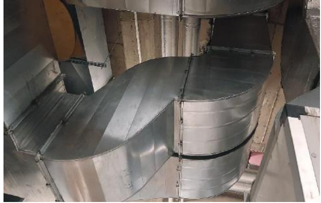
Fotoğraf 78: Su Hidroforu Arızası Tamiri ve Klima Santrali Hava Kanalı Tamirata İşi
