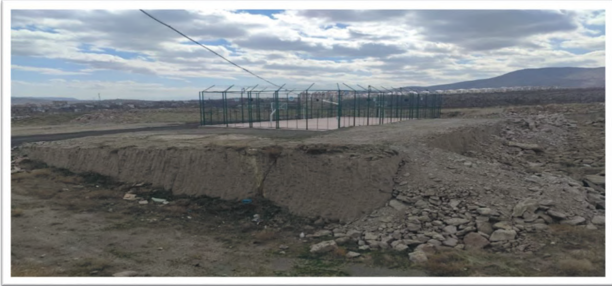
Fotoğraf 38: İncesu Yerleşkesi Açık Spor Sahası Çevresi
