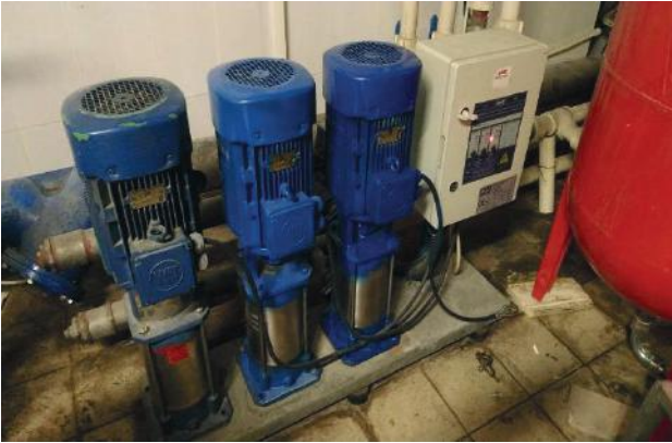
Fotoğraf 78: Su Hidroforu Arızası Tamiri ve Klima Santrali Hava Kanalı Tamirata İşi
