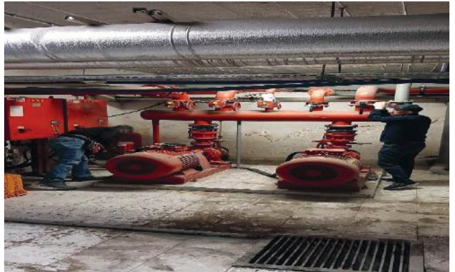
Fotoğraf 88: Mekanik Cihazların Periyodik Bakım Onarım ve Arızalarının Yapılması
